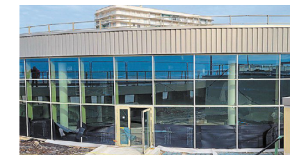
RÉHABILITATION DU CENTRE AQUATIQUE OCÉABUL
