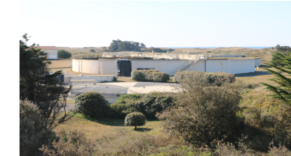
RÉHABILITATION DE LA STATION DE TRAITEMENT DES EAUX USÉES DES 60 BORNES
